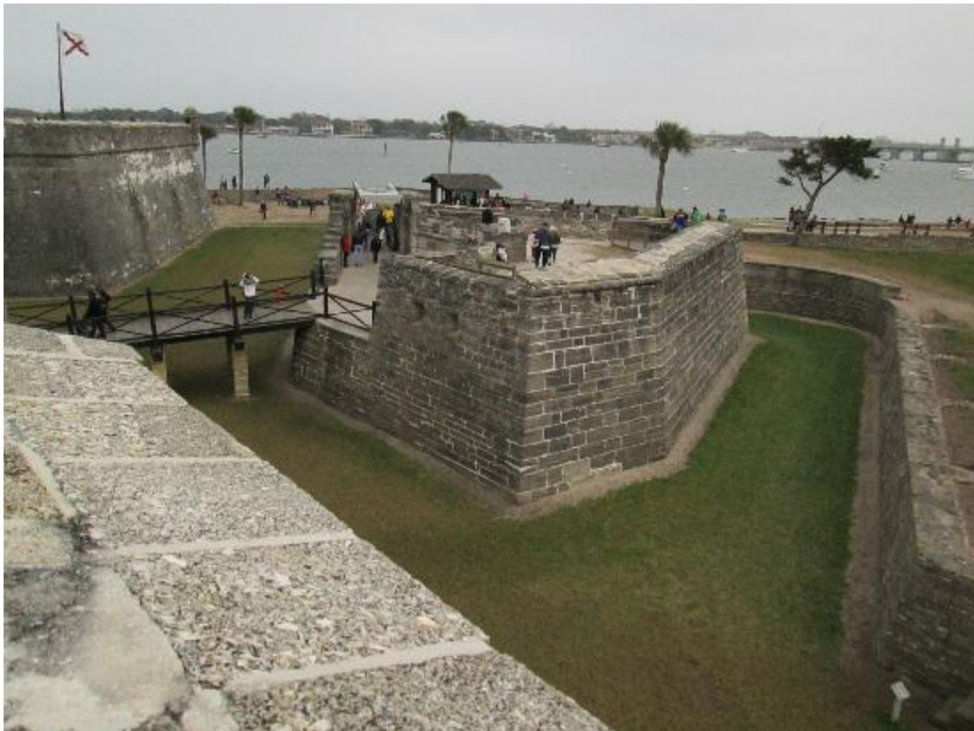
Muralla, foso y hornabeque exterior
